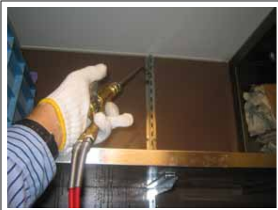
吊り棚 金属部分に電動コンプレッサーにて MC 剤を塗布しております。
