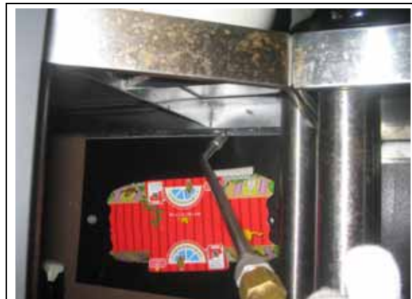
ステンレス台下部 ステンレスの折り返しの内部や天板の 裏部分に電動コンプレッサーにて MC 剤を塗布しております。
