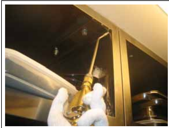
吊り棚 折り返し部分に電動コンプレッサーにて MC 剤を塗布しております。
